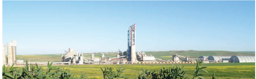
中材建设承建的境外水泥工程项目
