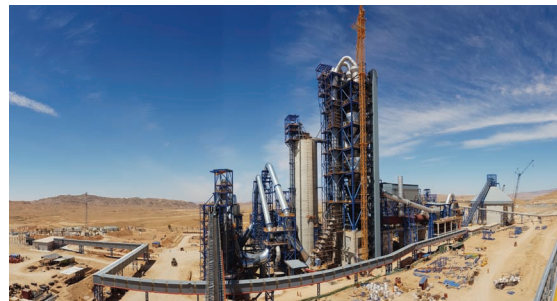
阿尔及利亚 BISKRA 项目施工现场
