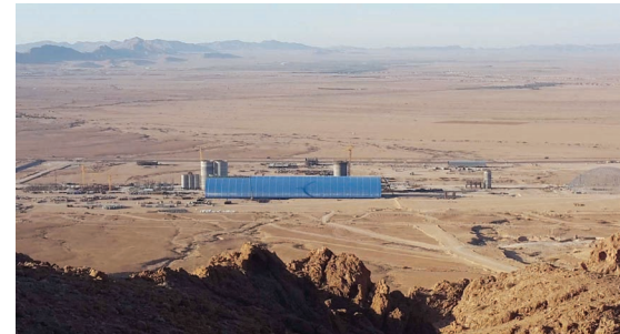
阿尔及利亚 BC 项目施工现场
